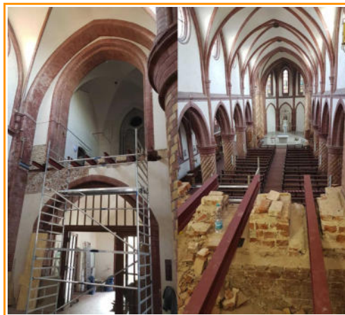
Nach der Sanierung wurden statt der Holzbalken Stahlträger in den Orgelboden eingesetzt und neu beplankt.
