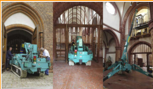
20.07.2019 Ausbau des Blasebalges zur Vorbereitung der Schwammsanierung
