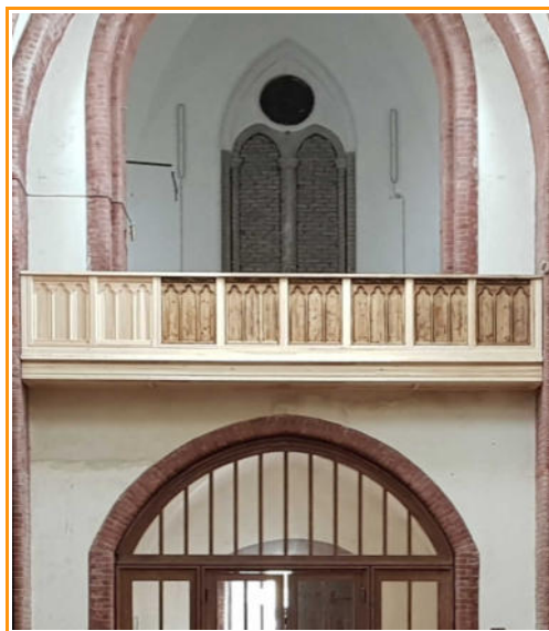
Für das Geländer der Empore wurden aufgearbeitete Segmente verwendet und integriert. Eine farbliche Anpassung wird erfolgen.
