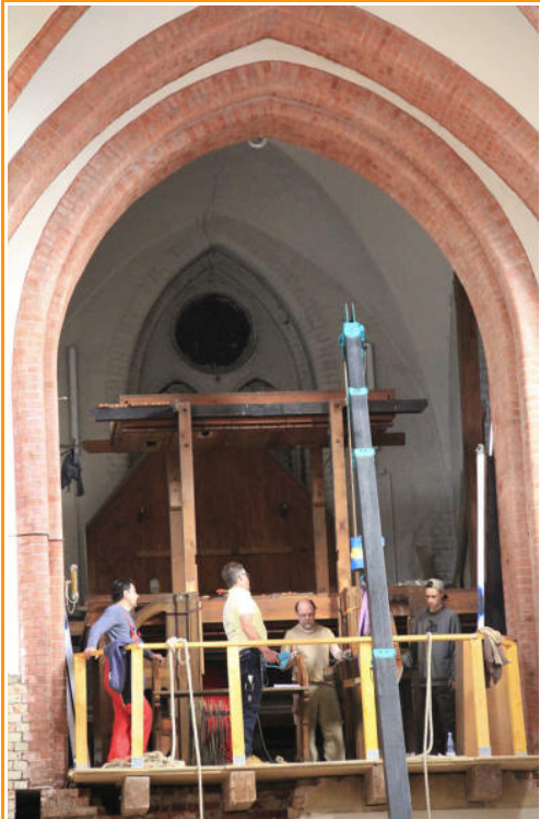
20.07.2019 Ausbau des Blasebalges zur Vorbereitung der Schwammsanierung
